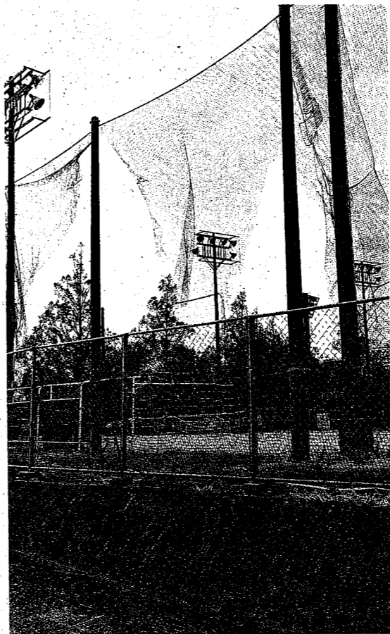
強風で裂かれたネット(恩田運動公園)
