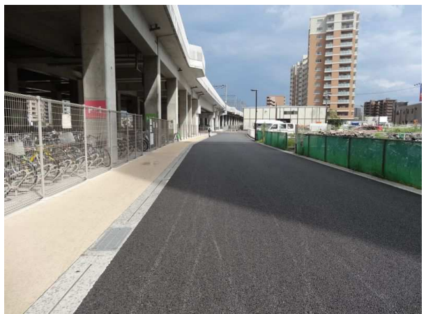
駅高架下の大型駐輪場から東に中央線の無い道路、シェアレーンの施工予定
